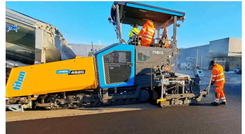
PEAB ASFALT: Tester batterielektrisk asfaltutlegger fra Ammann ABG i Sverige. Magnus Rockler / Ammann
