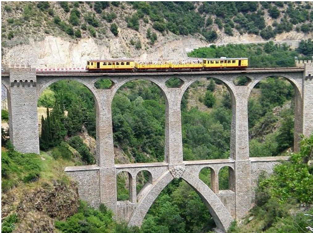
Figure 2-11: Pont de Paul Séjourné -Viaduc de Fontpedrouse- France
