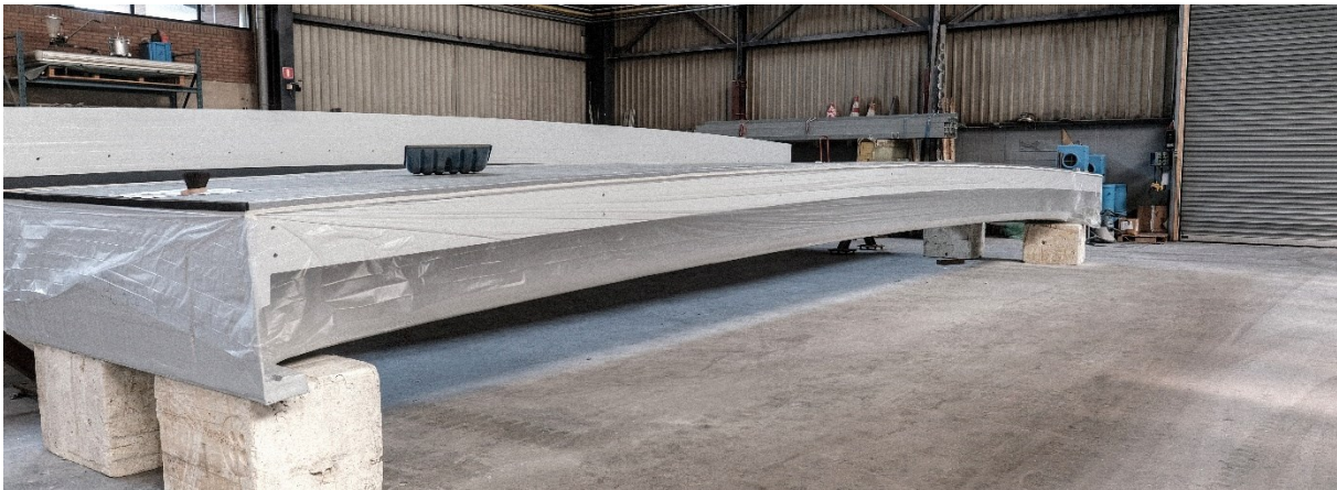
Figur 14 Ferdig bru med renskåret form og overflatebehandling. Slitelag og rekkverk mangler.
