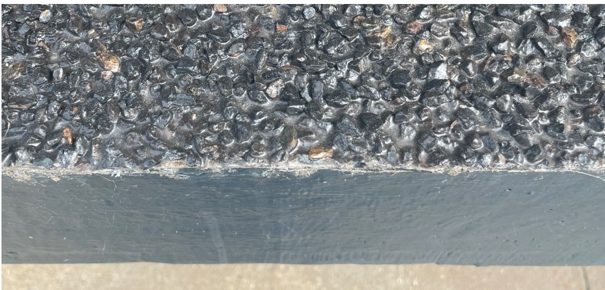
Figur 15 Komposittbru påført slitelag for vegbru før konstruksjonen plasseres i vegnettet.
