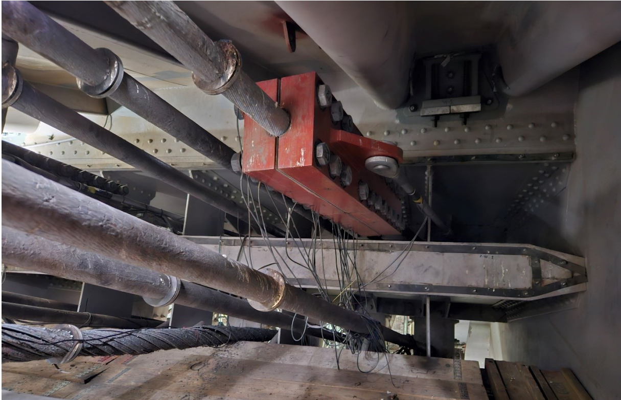
Figur 31 Klemme på avlastningssystemet.
