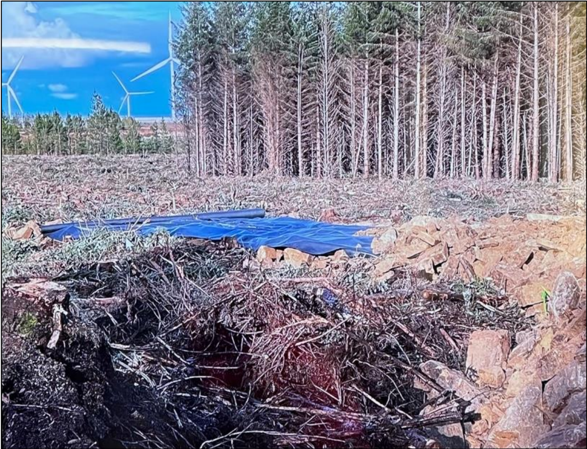
Figur 13: Bilde av bilde tatt av Farrans, vist under en presentasjon på dag 2. Legg merke til geotekstil som legges oppå steinlaget. Deretter legges det igjen et steinlag oppå geotekstilen.
