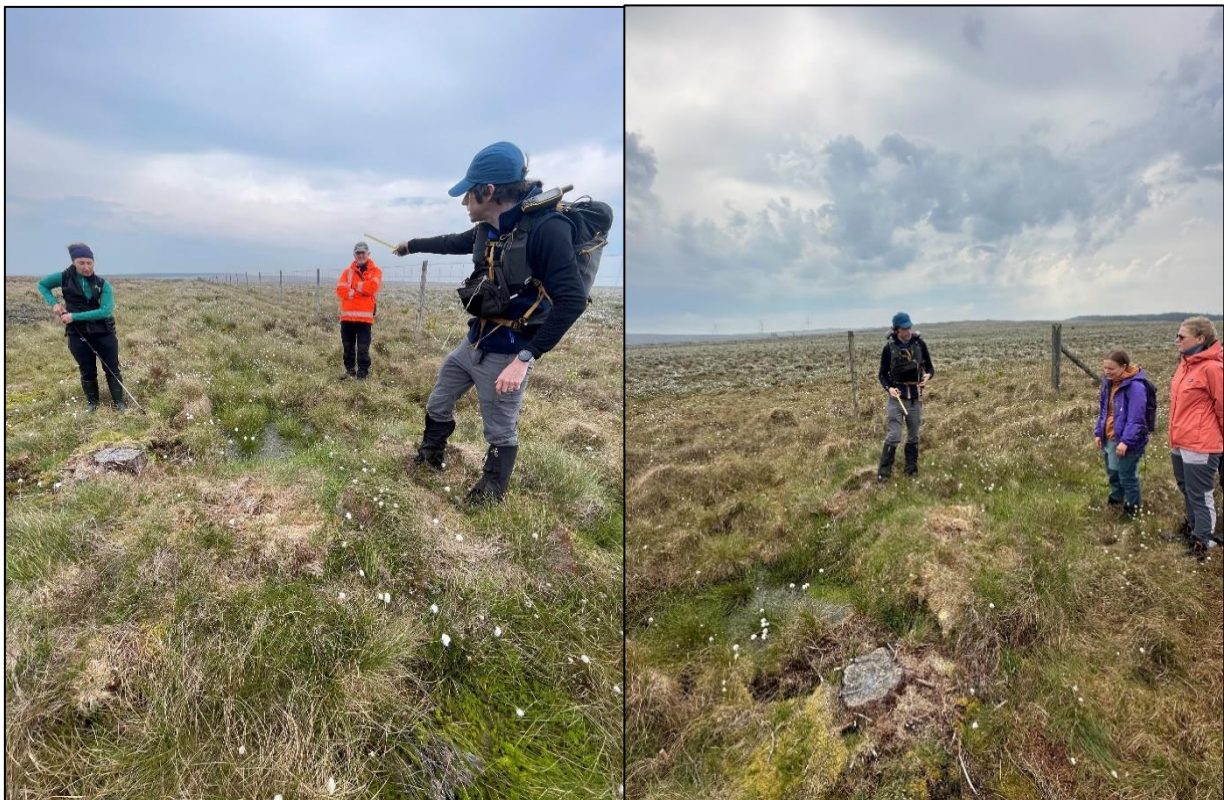
Figur 3a, b: a) Personen til høyre står på en blokkering i en drenert kanal. Legg merke til at blokkeringen ligger høyere i terrenget enn myren rundt. b) Samme blokkering, men fra en annen vinkel.
