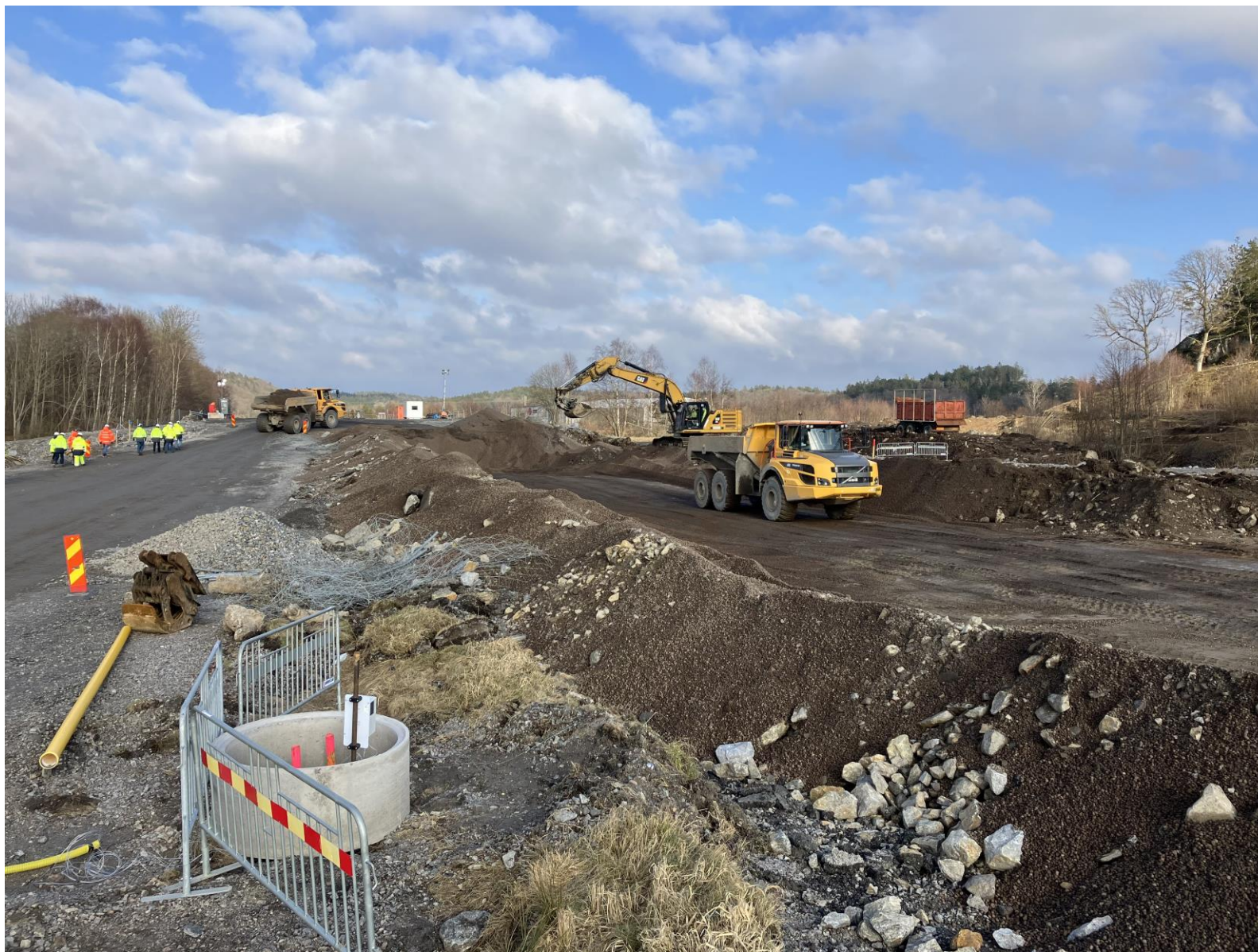
Avlastning av norrgående del E6
