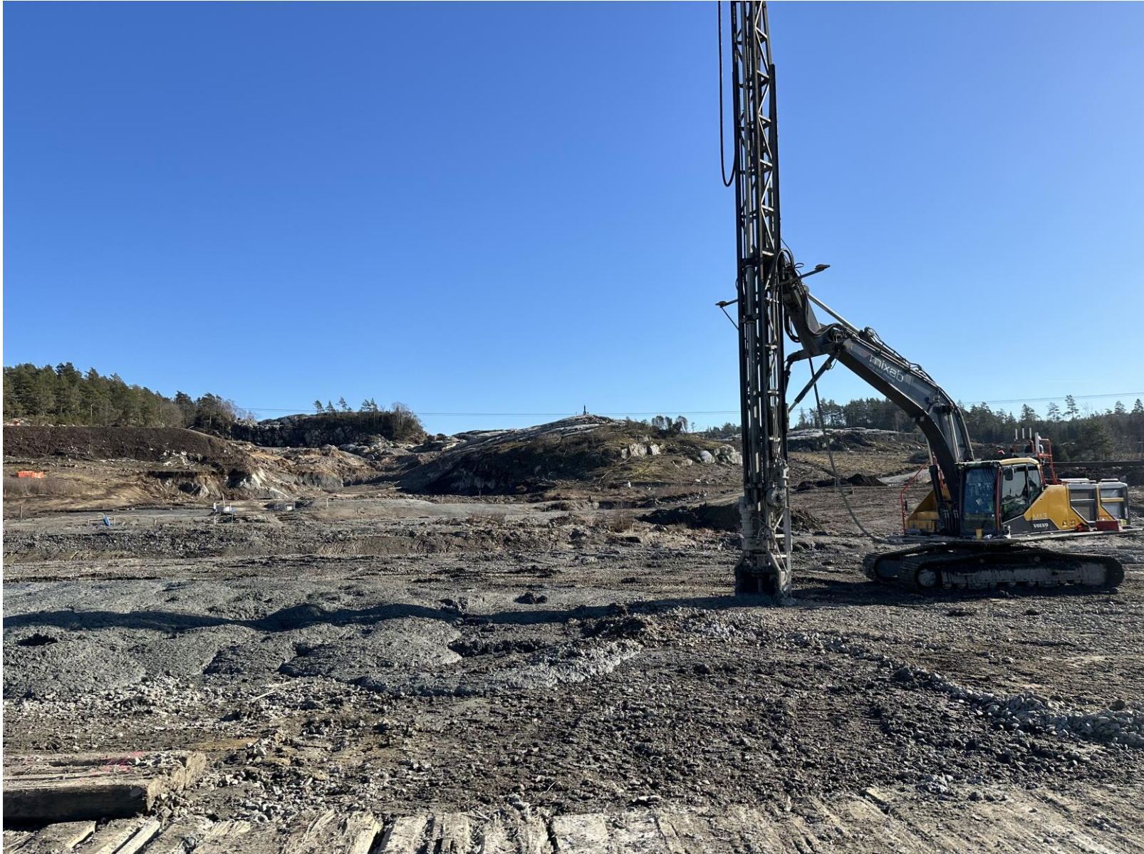
KC-pelarinstallation
