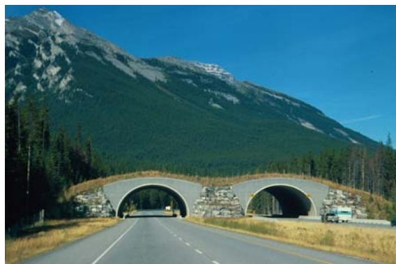
Fig. 18: Viltovergang “Wolverine Pass”, H1. Sørsiden.
