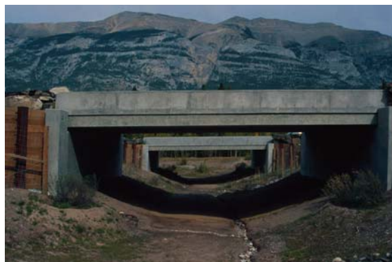
Fig. 27: Bru over viltkorridor, mye brukt av elk og til friluftsmål.
