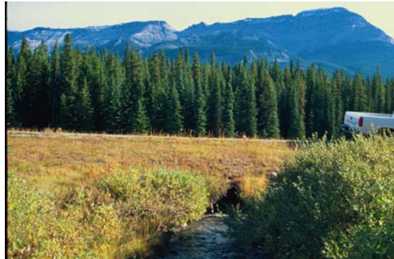
Fig. 25: Gjennomløp for bekk (H1), også brukt av ender.
