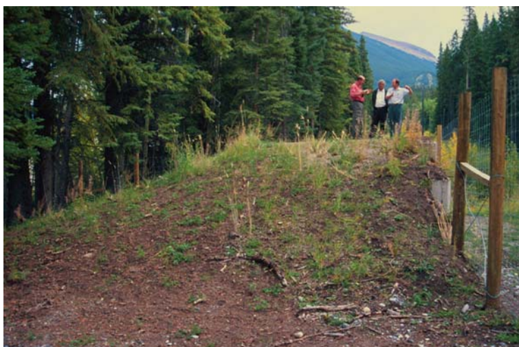
Fig. 15: “One way ramp”, fra innsiden kan dyr komme seg ut ved å hoppe ned fra en oppbygget jordvoll i hjørnet hvor viltgjerdet trekkes inn mot vegen.
