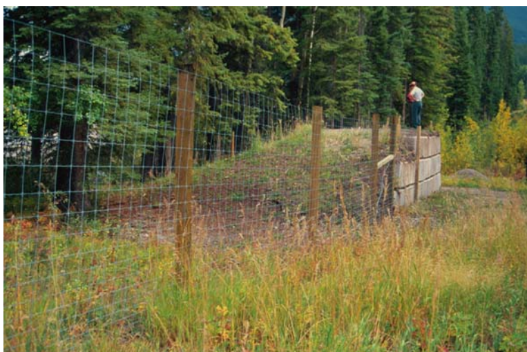
Fig. 16: “One way ramp”, sett fra utsiden av gjerdet. Jordvollen avsluttes i en loddrett mur omtrent i høyde med viltgjerdet, for høy til at viltet kan hoppe opp.
