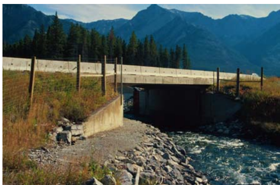
Fig. 24: Elveløp under H1 med passering for av vilt på oppbygget sti til venstre.
