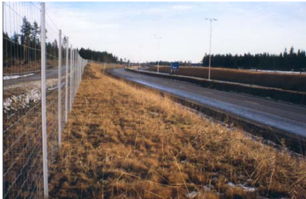
Fig 2: Viltgjerde rv 174 Viltgjerde
