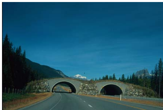
Fig. 20: Viltovergang “Red Deer Pass”, H1. Sørsiden.
