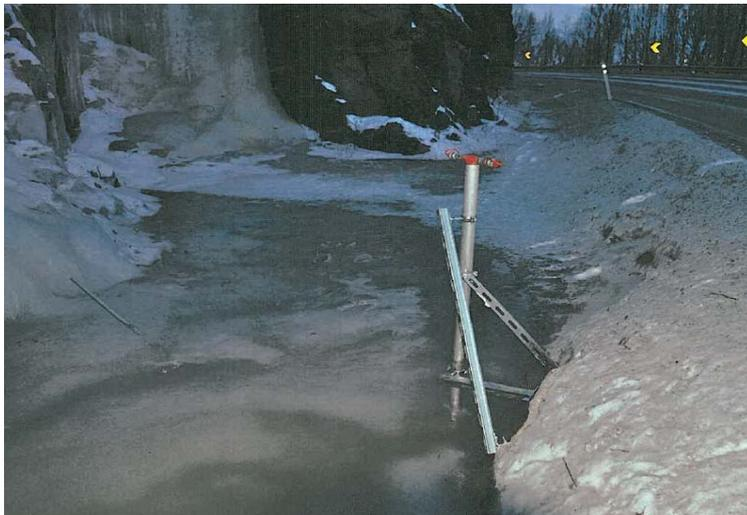
*IceGuard systemet montert på stikkrenne ved kjent problempunkt. Foto: HeatWork.*
