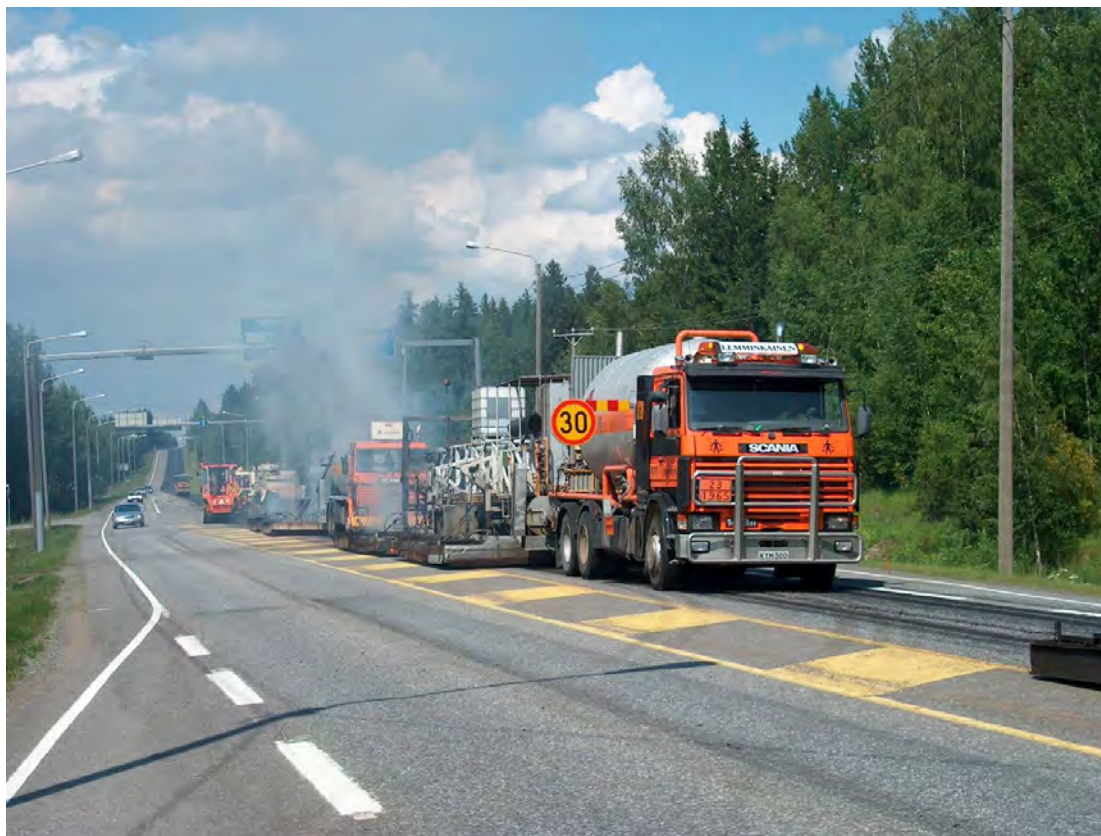
Bild 5. Normal rökutveckling vid Remixer-arbete.
