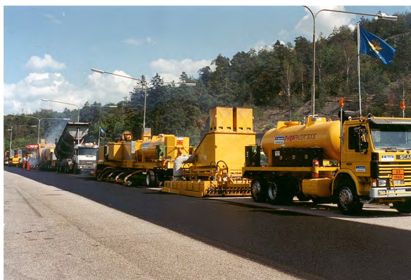
Bild 6. Exempel på en Remixer-utrustning, som förbränner rökgaserna från den uppvärmda beläggningen.
