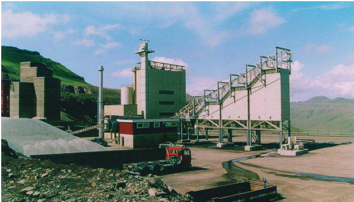
Asfaltværket i Hundsarabotn
