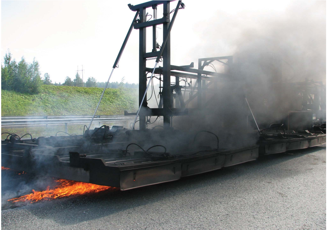
Bild 2: Brinnande markeringsmassa producerade tjock rök. (Lemminkäinen, riksväg 3)
