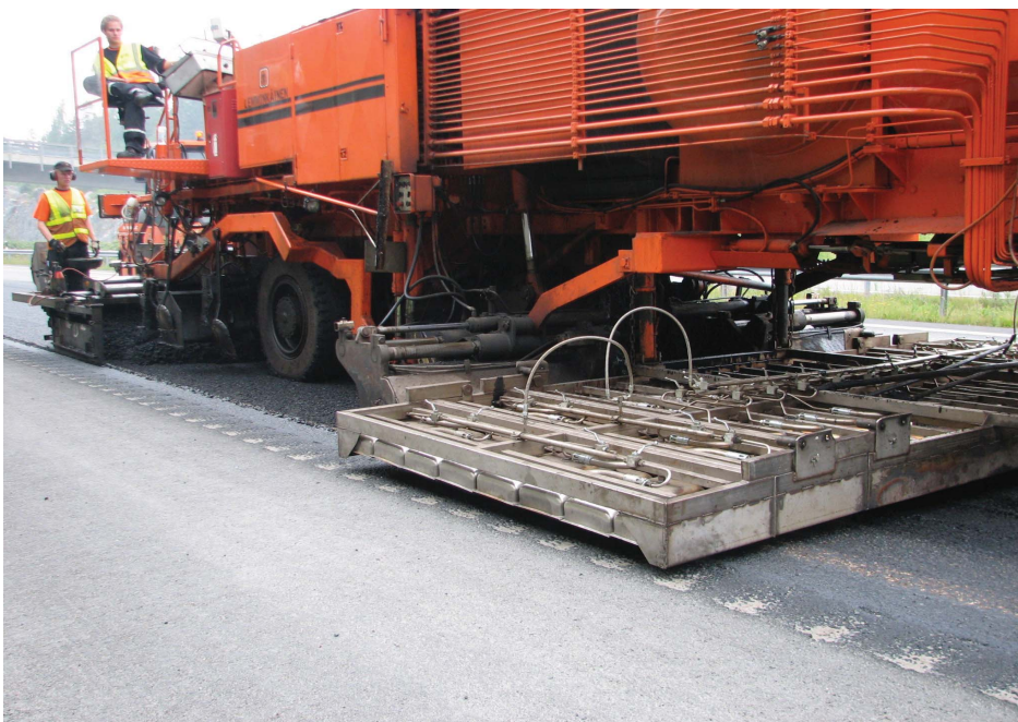
Bild 1: En extravärmare förr fräsmaskinen. (Lemminkäinen, riksväg 3)
