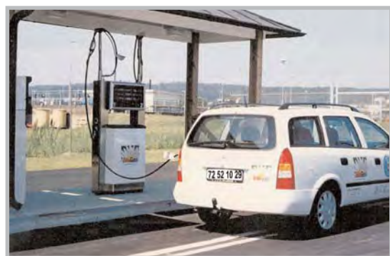
Tankanlegg for CBG (compressed biogas) slik en finner det i Jönköping
