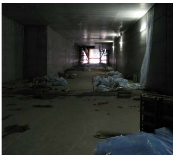
Figur 3: Ferdig støpt konstruksjon.
