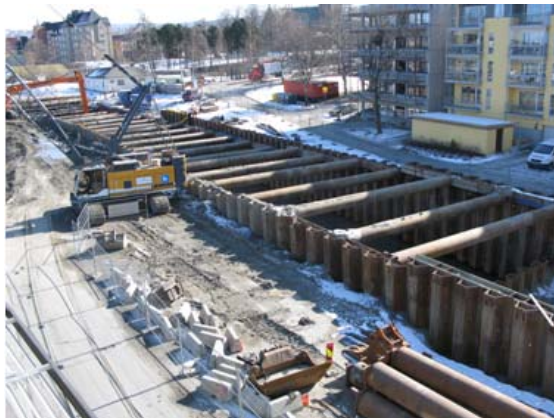
Figur 2: Bilde viser utgraving av spuntet byggegrop.
