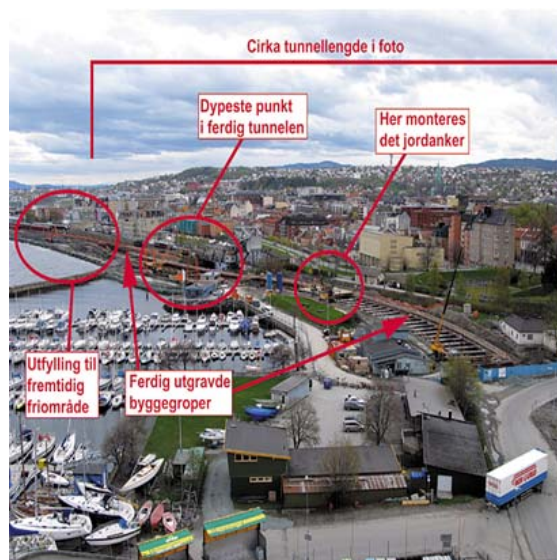
Figur 1: Oversiktsbilde over første ledd i bygging av Skansenløpet betongtunnel.
