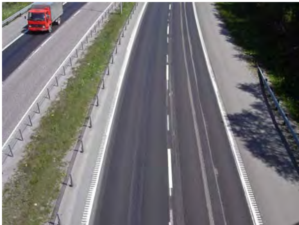
Spordybdeparasjoner v/sporfyllingstiltak på E6 nord for Oslo 2006
